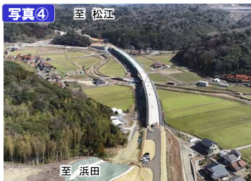
常楽寺第二高架橋付近
