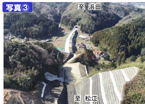
神西トンネル付近
