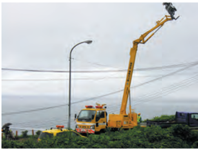
照明車による災害復旧支援
