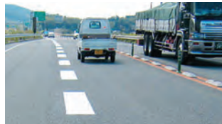
走行範囲を表す区画線設置
