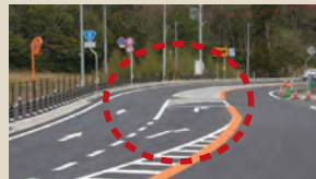
市道への右折車線の設置
