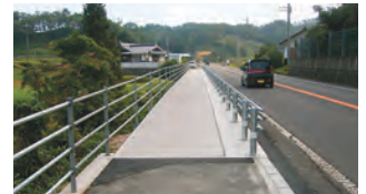
安心して歩行できる空間を確保する歩道設置
