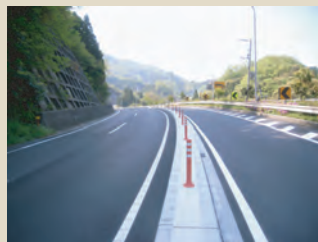
カーブ区間は、中央分離帯、キャッツアイを設置
