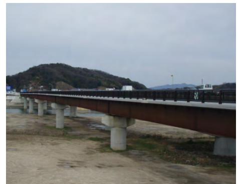
里熊大橋側道橋整備状況
