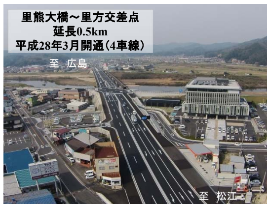
里熊大橋 広島方面を望む
