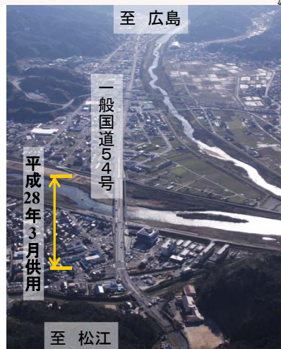
上空より里熊大橋周辺を望む
