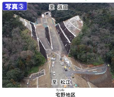
状況写真 R5年2月時点
