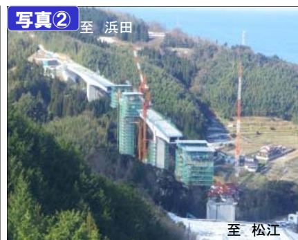
おだ 小田第1高架橋
