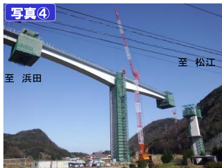
くちたぎ 口田儀第4高架橋
