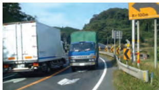
線形不良箇所（大田市朝山町R=100m）
