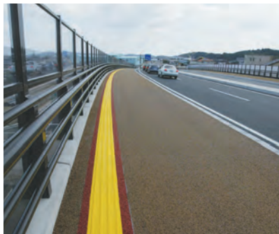
【松江道路玉湯工区バイパス部分】点字ブロック両側には舗装色と見分けやすいボーダー(縁どり)を設けています。
