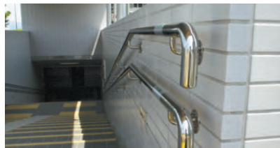
【穴道湖夕日スポット】子供から大人、そして高齢者の方でもつかまりやすい2段手すり。
