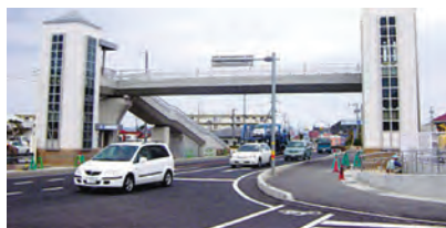
【多伎 夢・みらい橋】「多伎町交通バリアフリー基本構想」に基づいて設置したエレベータ付き歩道橋。
