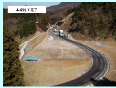
7. 湯里地区改良工事
