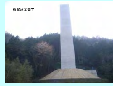
10. 小浜第1高架橋下部第1工事
