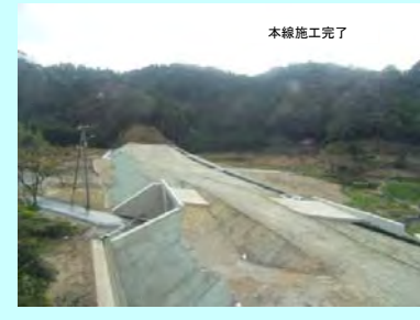
8. 清水地区改良工事
