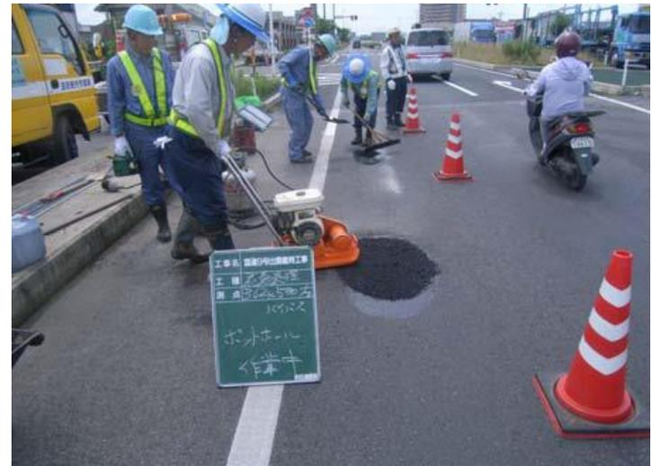
舗装の応急補修（ポットホール補修）
