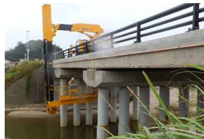
橋梁点検の様子
