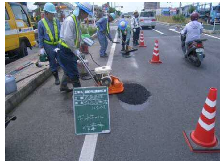
舗装の応急補修(ポットホール補修)
