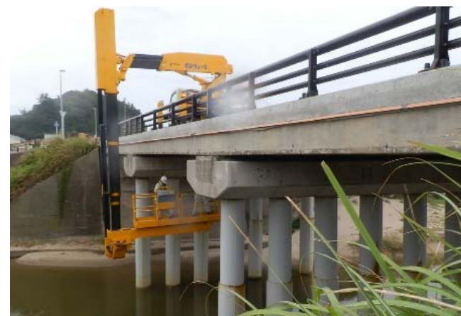
橋梁点検の様子
