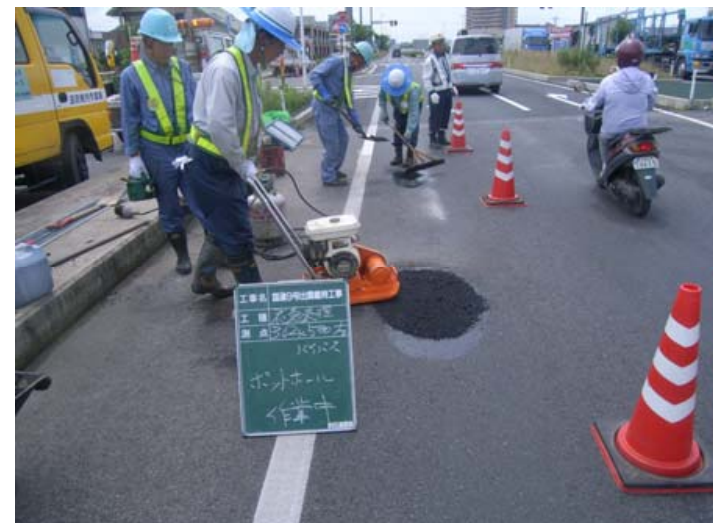
舗装の応急補修（ポットホール補修）
