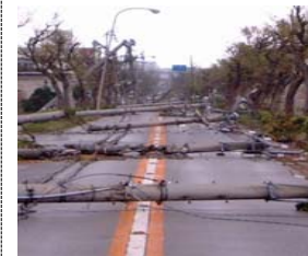
＜電柱の倒壊による道路閉塞の事例＞
