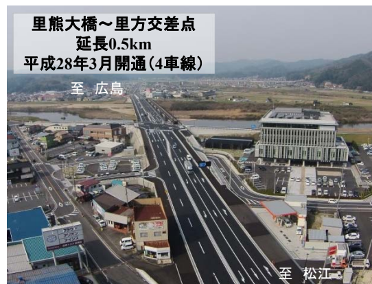
里熊大橋 広島方面を望む
