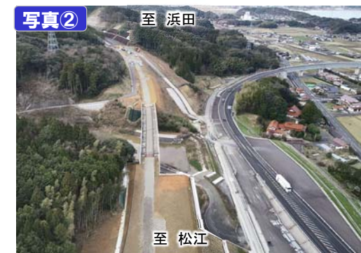
至 松江 東神西第一高架橋付近
