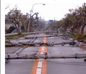
＜電柱の倒壊による道路閉塞の事例＞
