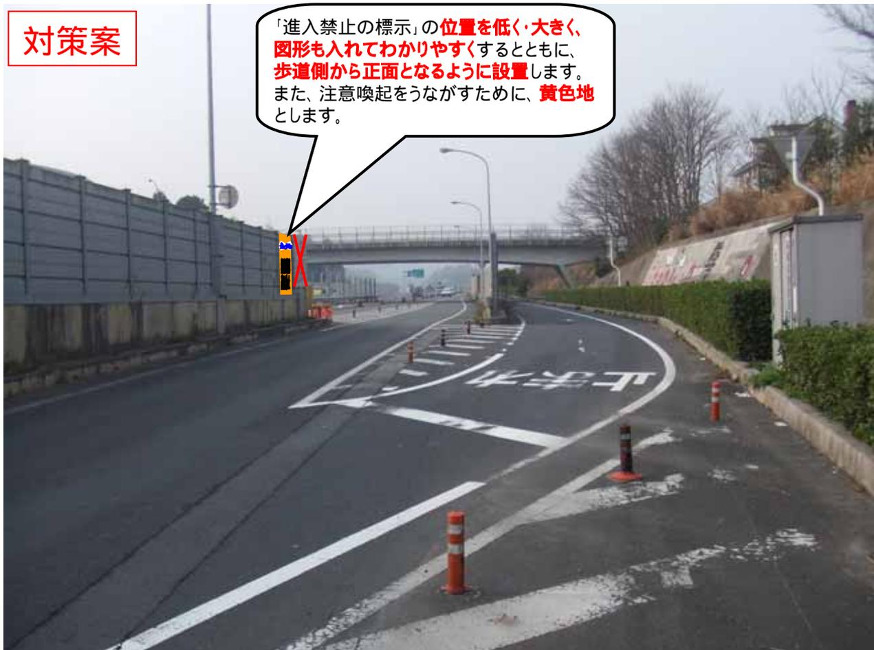
「進入禁止の標示」の位置を低く・大きく、**図形も入れてわかりやすく**するとともに、**歩道側から正面となるように設置**します。また、注意喚起をうながすために、**黄色地**とします。
