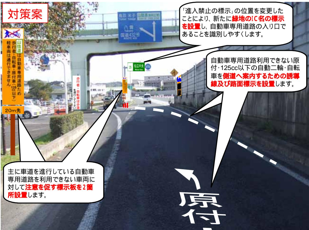
「進入禁止の標示」の位置を変更したことにより、新たに**緑地のIC名の標示を設置**し、自動車専用道路の入り口であることを識別しやすくします。
