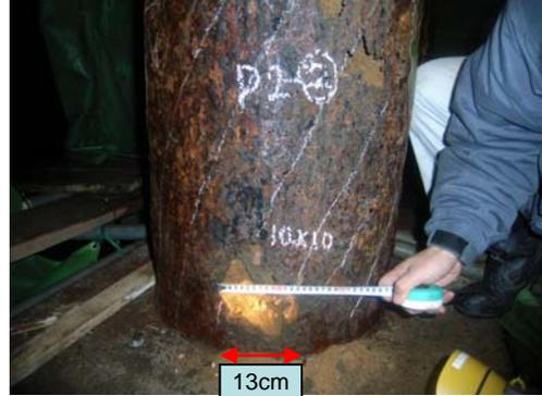
写真③P2橋脚基部 損傷部(P2-4)
