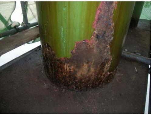
写真②P2橋脚基部 損傷部(P2-2)
