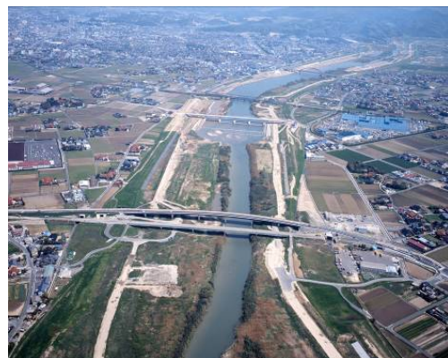
国道9号神戸橋及び神戸堰
