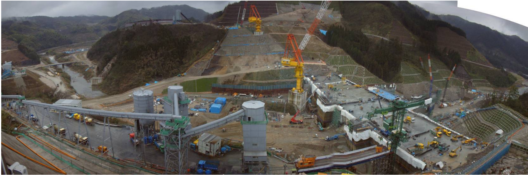
ダム本体施工状況(右岸より左岸を望む)
