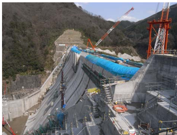
左岸より右岸を望む
