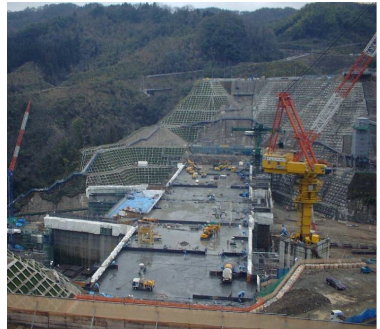
ダム本体施工状況(左岸より右岸を望む)
