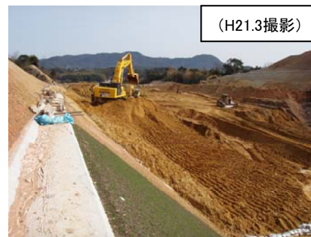
原浜地区 整備状況
