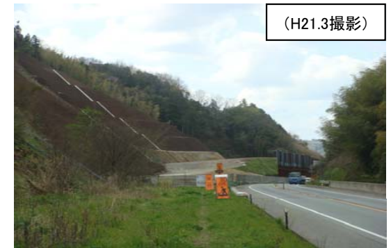
原井地区 整備状況
