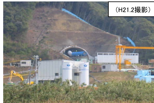
塚ヶ原山トンネル工事 整備状況
