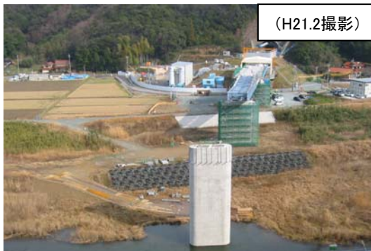
周布川大橋上部工事 整備状況
