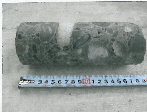
橋梁から採取したコアの例 (※ASRが生じた事例ではない)
