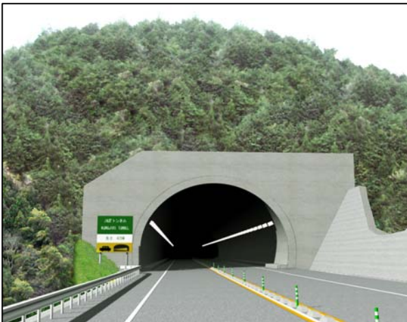
北側(松江側)坑口
