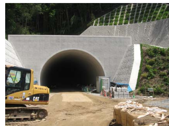
上熊谷トンネル(H22. 1完成)
