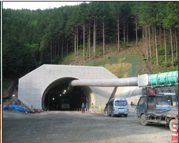
南側(三次側)坑口現況
