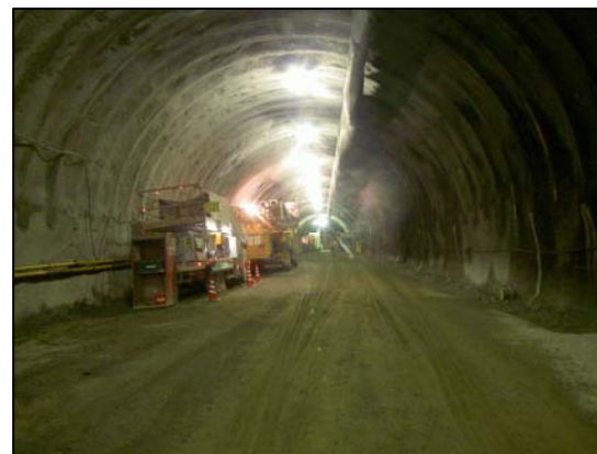
川尻トンネル(今回貫通)
