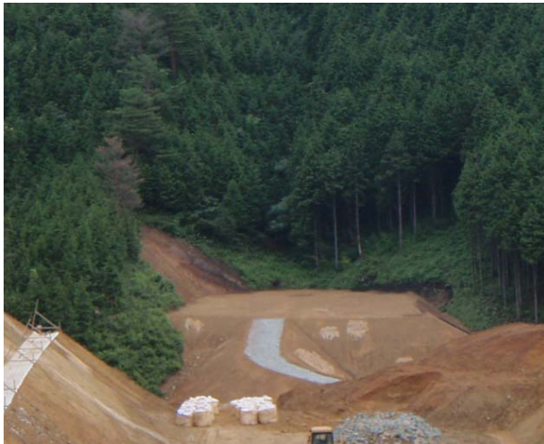
南側(三次側)坑口着手前
