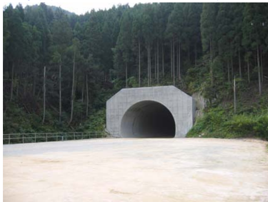
高瀬山トンネル(H21. 9完成)
