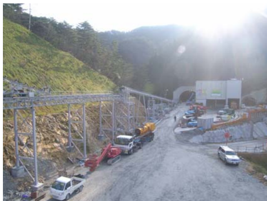
大万木トンネル(施工中)
