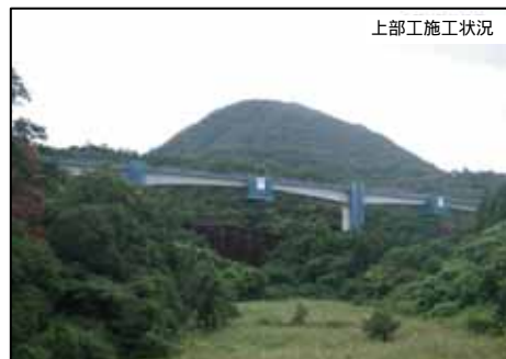
馬路第2高架橋PC上部工事
