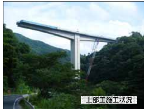
吉田川橋PC上部工事
