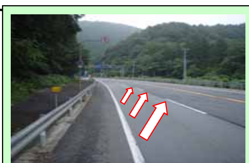
絞り込み矢印を手前から設置
