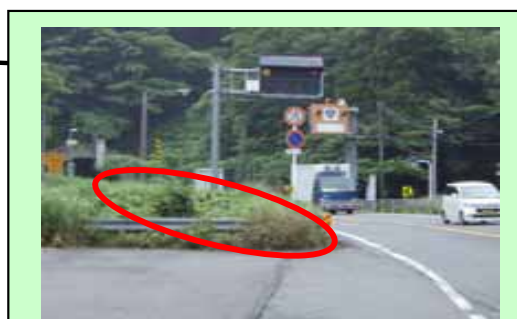
坑口左側の除草(実施済み)
