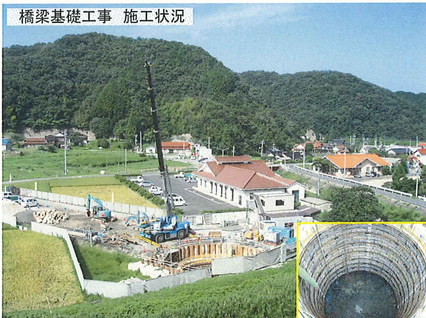
湯里高架橋下部第2工事
