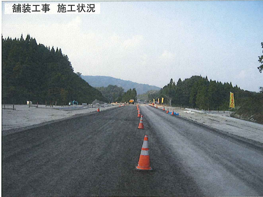
下熊谷地区舗装工事
