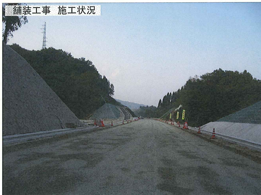
舗装工事現場 (箇所は未定)
