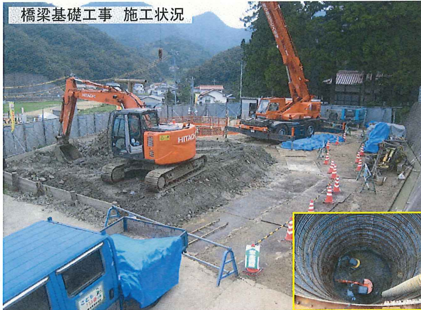
湯里高架橋下部第3工事
