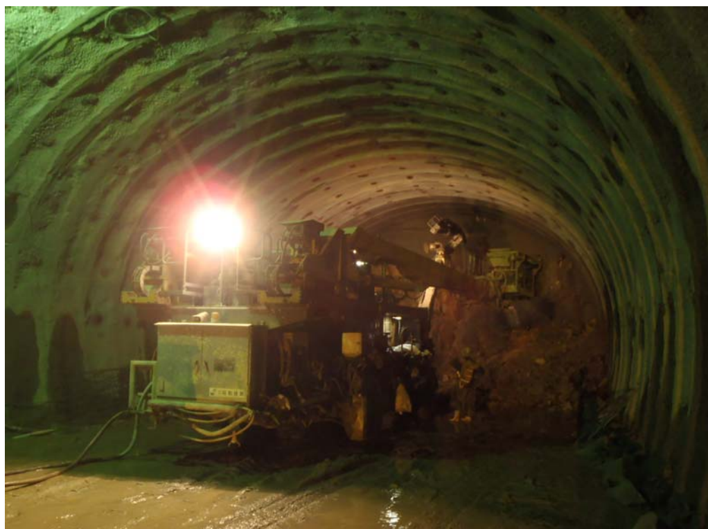
トンネル掘削状況（平成24年5月）
