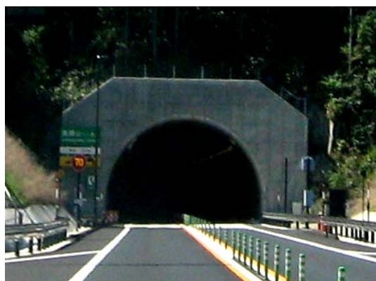
高瀬山トンネル(H24. 3供用済)
