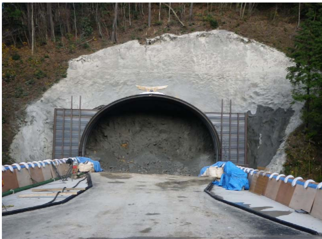
トンネル掘削開始（平成23年11月）
