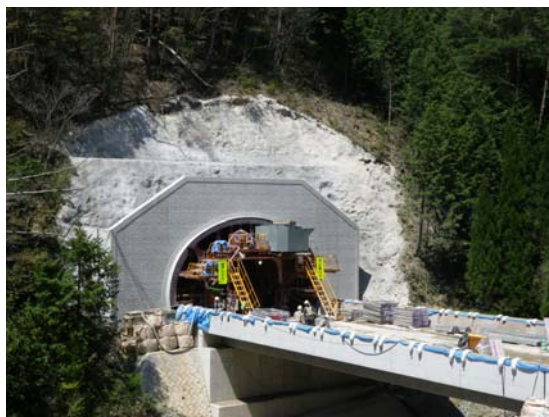
杉戸トンネル(今回貫通)
