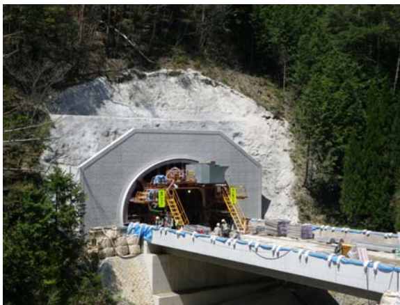
トンネル(杉戸トンネル)
