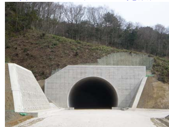
吉田トンネル(H22. 3完成)
