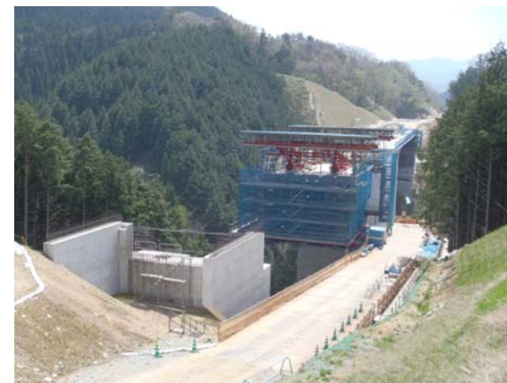
橋梁上部工(後谷川橋)
