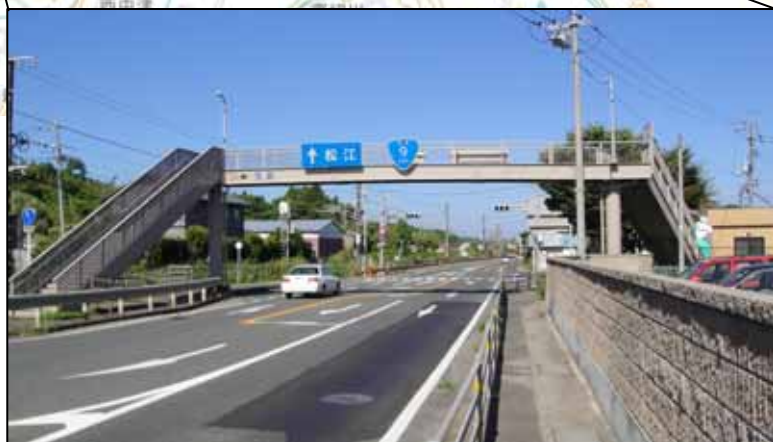
荒島歩道橋 全景
