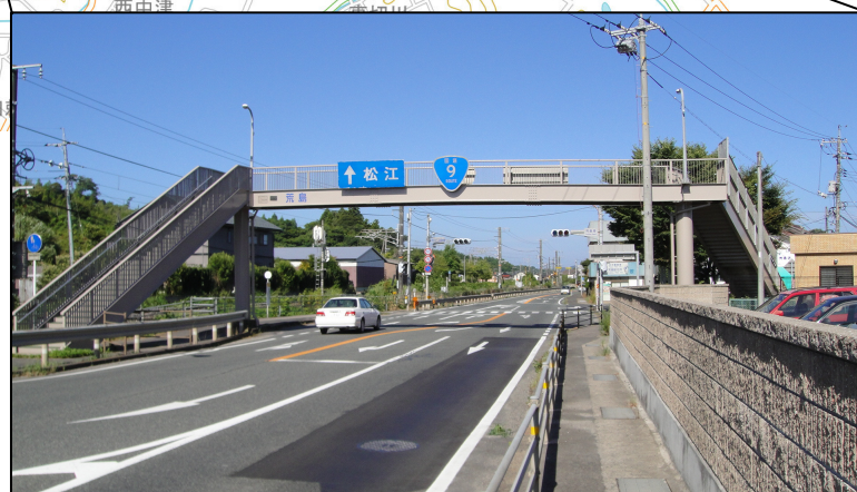
荒島歩道橋 全景
