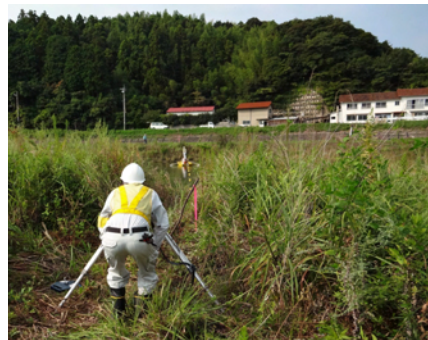
測量調査状況
