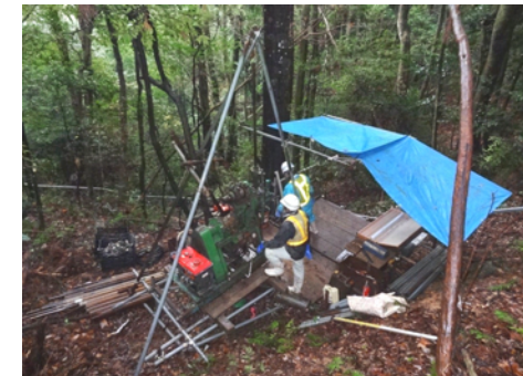
地質調査状況
