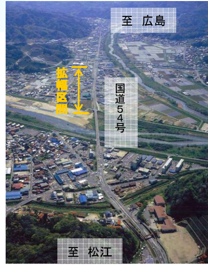
上空より拡幅区間を望む(三刀屋町地内)
