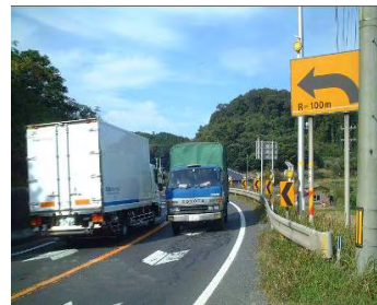
線形不良箇所 (大田市朝山町 R=100m)
