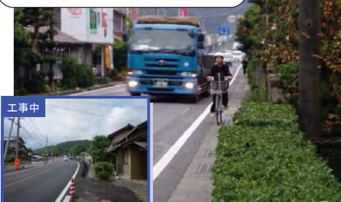
③8 国道9号 益田市横田町：歩道設置工事中（迂回路設置）
