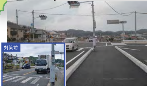
②4 国道9号 浜田市国分町：交差点改良，歩道拡幅実施
