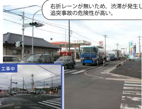
⑪ 国道9号 斐川町荘原中央西：交差点改良工事中
