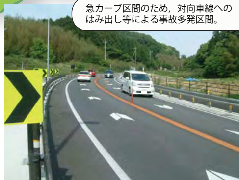
⑮ 国道9号 大田市朝山町朝倉：線形改良実施
