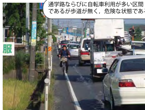
⑤ 国道9号 松江市東出雲町揖屋～出雲郷：歩道拡幅，交差点改良工事中
