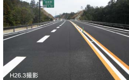
写真⑤ 舗装施工状況(福波地区)
