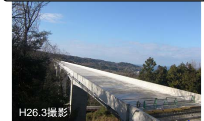
写真② 上部施工状況(馬路第1高架橋)
