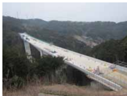
折居川橋PC上部工事 整備状況
