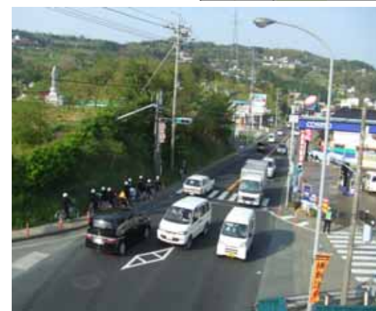
浜田市熱田町 事故対策予定箇所
