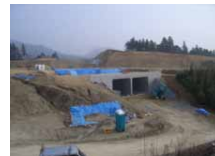
三隅地区外第2改良工事 整備状況
