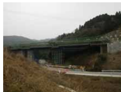
内田高架橋PC上部工事 整備状況
