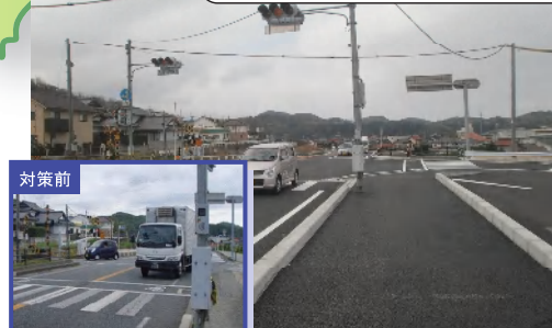
②④ 国道9号 浜田市国分町：交差点改良、歩道拡幅実施済
