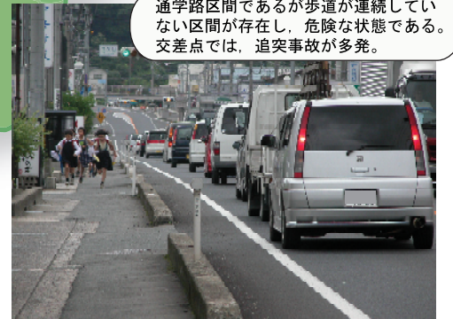
④ 国道9号 松江市東出雲町揖屋五反田：交差点改良工事中
