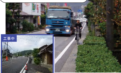
③⑧ 国道9号 益田市横田町：歩道設置工事中（迂回路設置）
