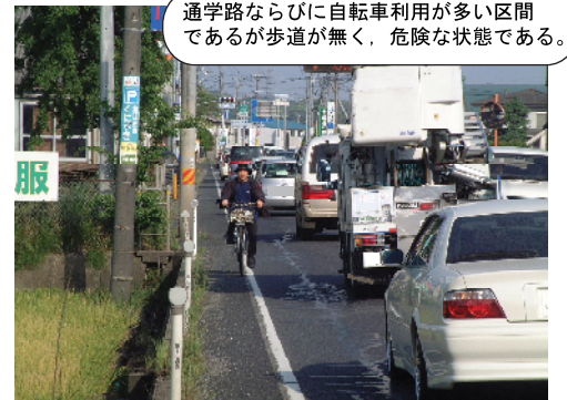
⑤ 国道9号 松江市東出雲町揖屋～出雲郷：歩道拡幅、交差点改良工事中
