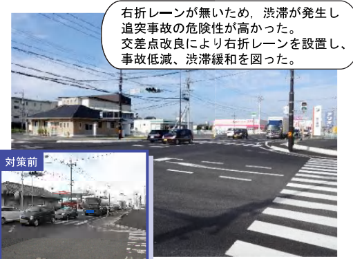
⑪ 国道9号 斐川町荘原中央西：交差点改良実施済
