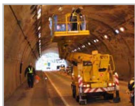
トンネル点検車によるトンネル点検。
