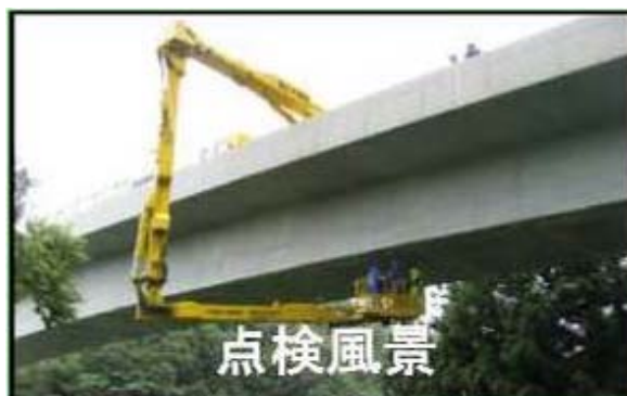
橋梁点検車による橋梁点検。
