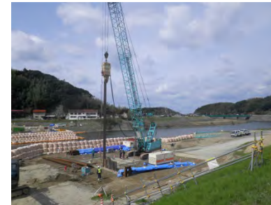
三隅川橋 整備状況
