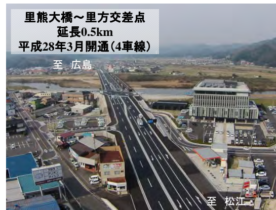
里熊大橋 広島方面を望む
