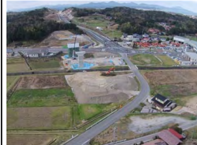
遠田高架橋 整備状況
