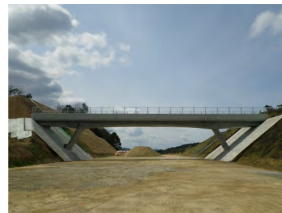
折居跨道橋 整備状況
