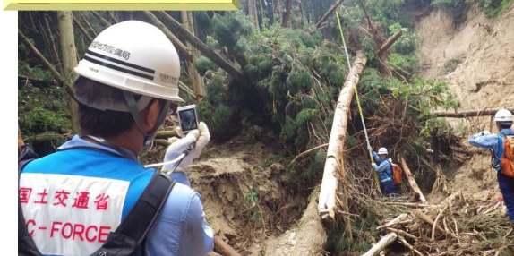
【H26.8 広島土砂災害】 (広島県広島市)
