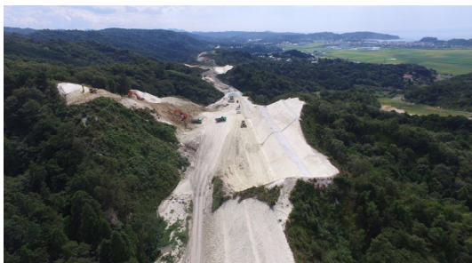
工事現場の状況(起点より)
