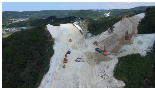
工事現場の状況(終点より)
