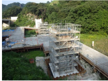
工事現場の状況(7月末現在)
