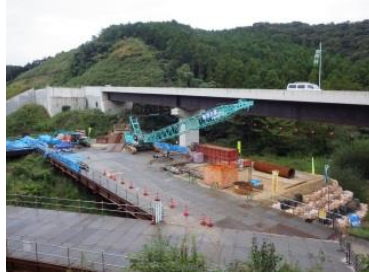
工事現場の状況(9月末現在)
