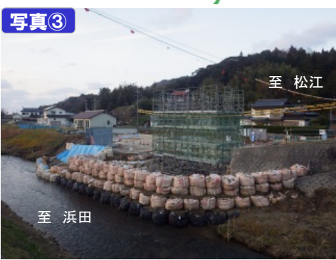
写真③ 仁摩IC橋
