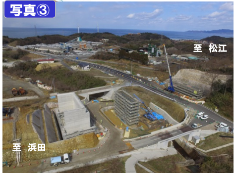
多伎IC(仮称)付近 多伎IC橋
