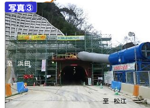
くちたぎ 口田儀第1トンネル
