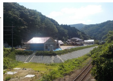
宅地嵩上げ整備箇所(松川橋付近)
