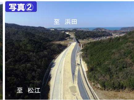
はねがわ 施工状況 (羽根川橋付近)
