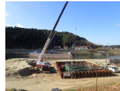
三隅川橋 整備状況
