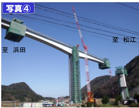
くちたぎ 口田儀第4高架橋
