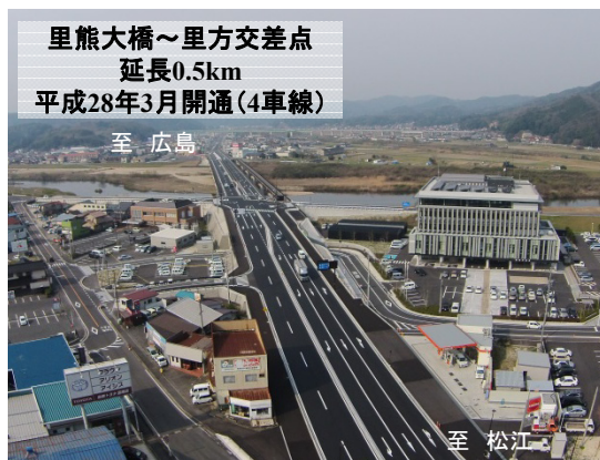
里熊大橋 広島方面を望む
