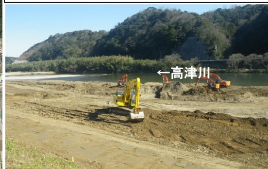
<掘削状況写真>
