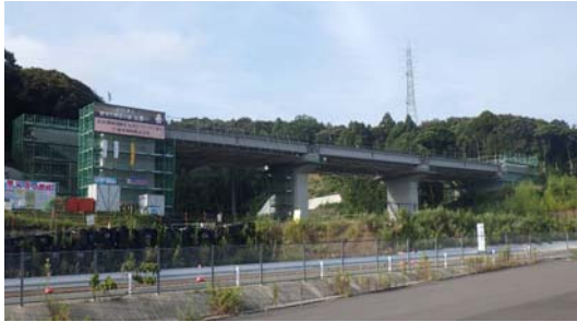
工事現場の状況(全景)
