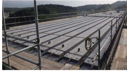
工事現場の状況(近景)
