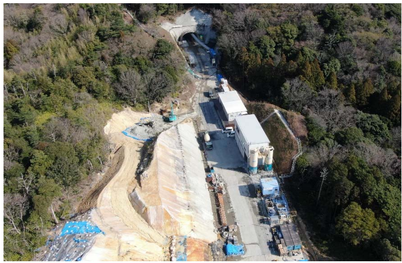
【五十猛トンネル工事の坑口付近】
