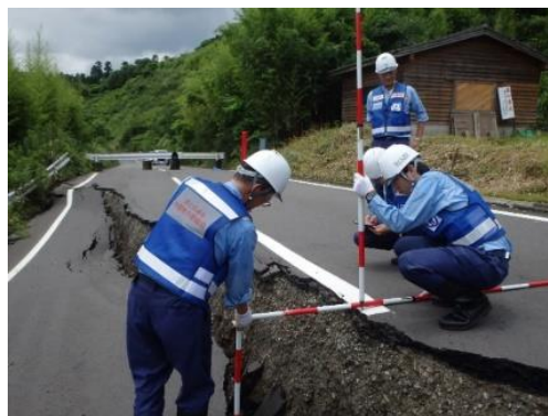
被災状況調査イメージ
