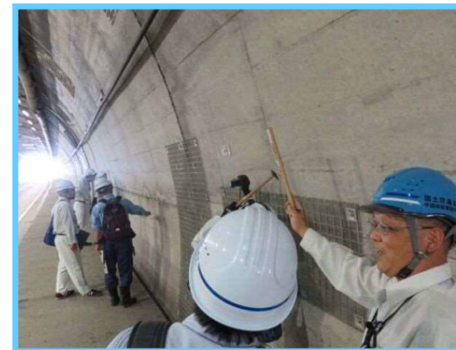
トンネル管理実務者研修
