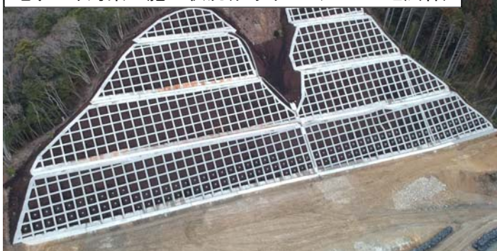
地すべり対策の施工状況(グラウンドアンカーと法枠)
