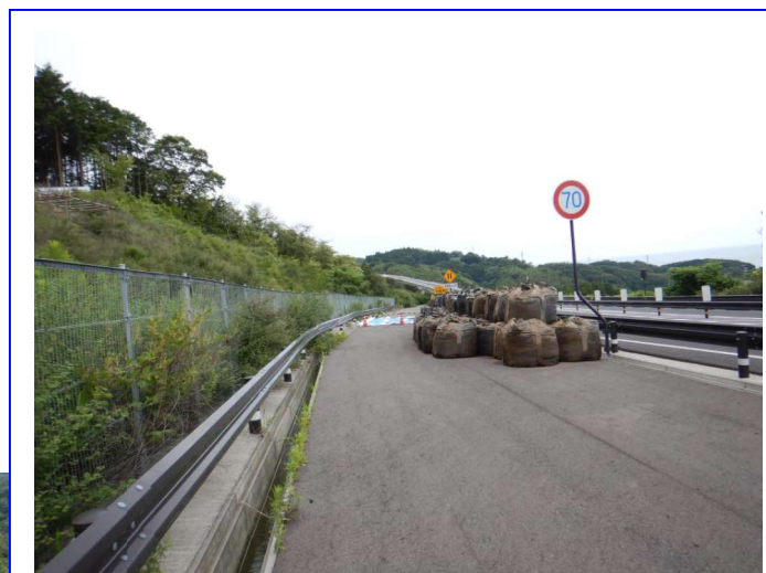
応急流出防止対策(大型土のう)設置状況
