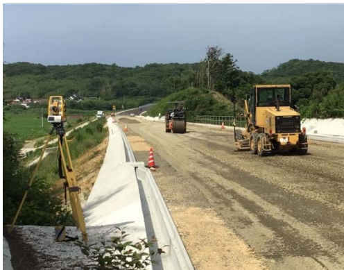
ICT施工見学
