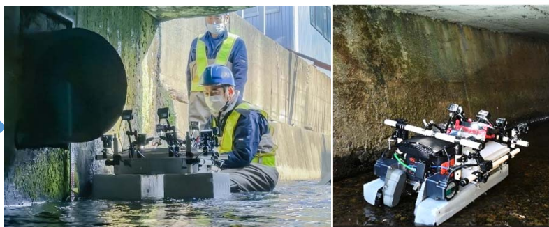
■新技術(MCS)による橋梁点検
