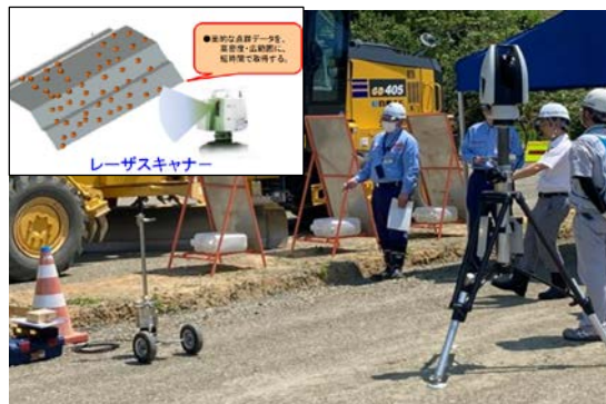
レーザー Scannerによる舗装面の3次元計測
