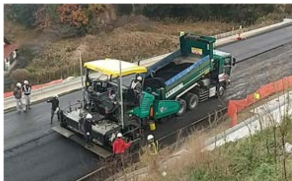
ICT施工機械（3D-MCフィニッシャ）による舗装作業
